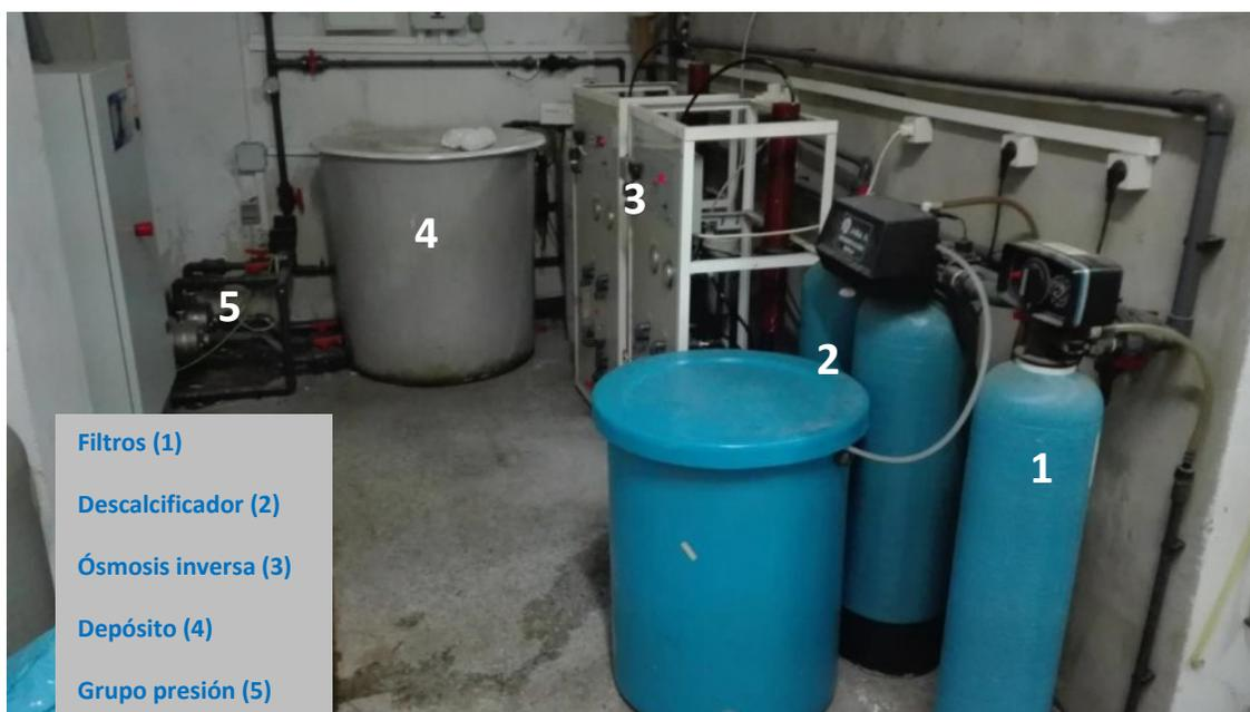
**Figura 14.-** Fotografía de la estación de tratamiento de agua situada en la planta baja de la Facultad de Farmacia.
